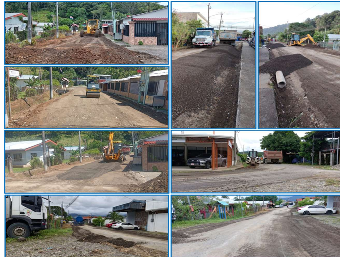
OBRAS DE CONFORMACION
