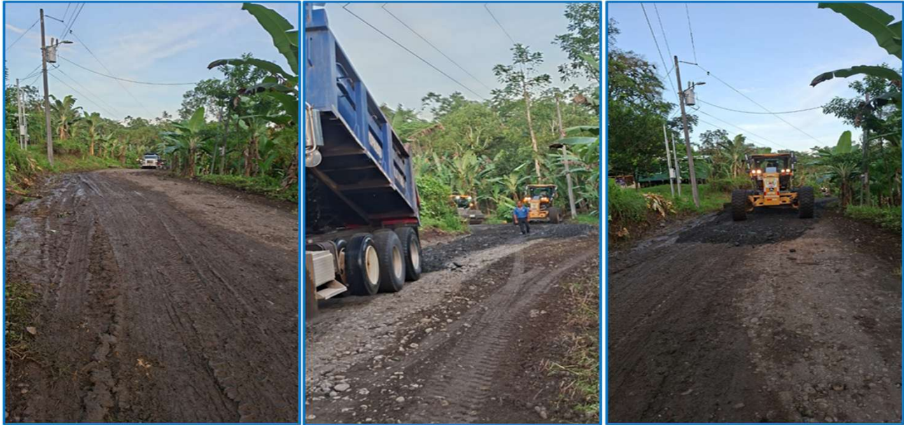
COLOCACION DE LASTRE, NIVELACION, COMPACTACION Y CONFORMACION DE SUPERFICIE DE RUEDO
