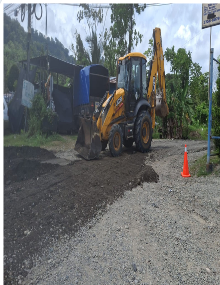
MAQUINARIA EN CAMPO
