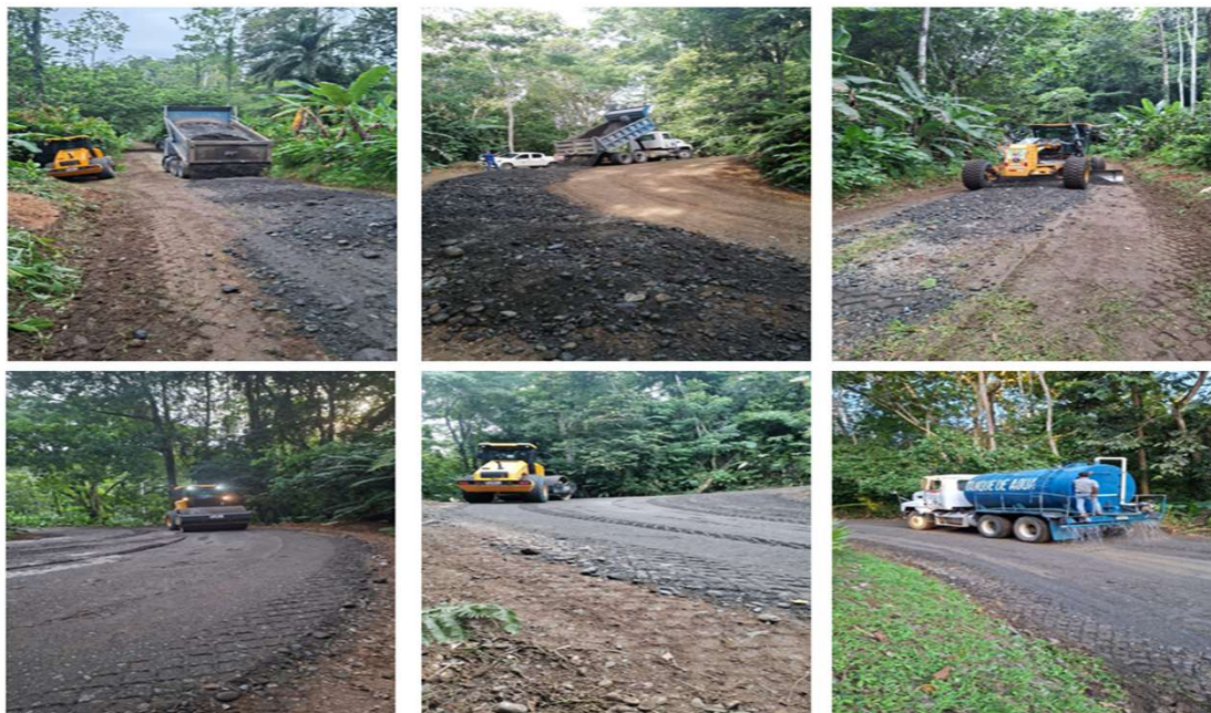
COLOCACION DE LASTRE Y CONFORMACION DE SUPERFICIE DE RUEDO
