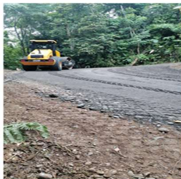
COLOCACION DE LASTRE Y CONFORMACION DE SUPERFICIE DE RUEDO
