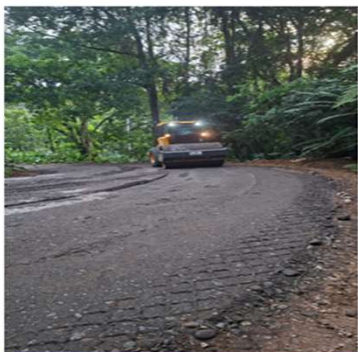
COLOCACION DE LASTRE Y CONFORMACION DE SUPERFICIE DE RUEDO
