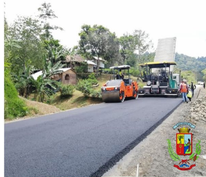
1KM ADICIONAL DE ASFALTO PARA EL CAMINO ENTRE BRIBRI - SURETKA
