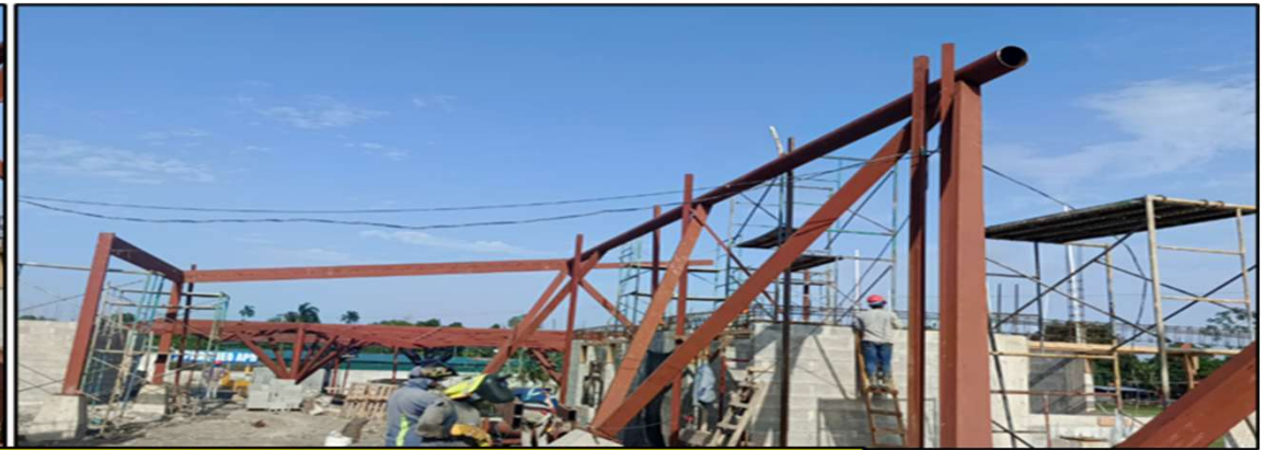
INICIO COLOCACION ESTRUCTURA METÁLICA DEL PASILLO DE LOS LOCALES
