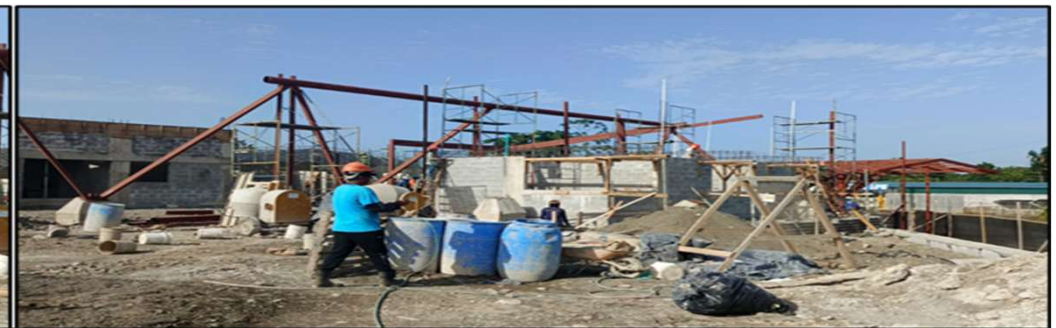
TAPICHELES DE BLOCK EN LOCALES Y LEVANTADO DE PARED EN AREA DE BOLETERIA DE MEPE
