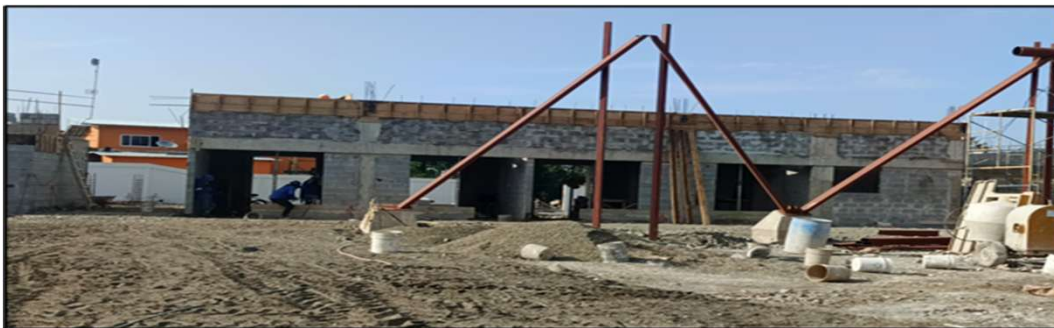
TAPICHELES DE BLOCK EN LOCALES Y LEVANTADO DE PARED EN AREA DE BOLETERIA DE MEPE
