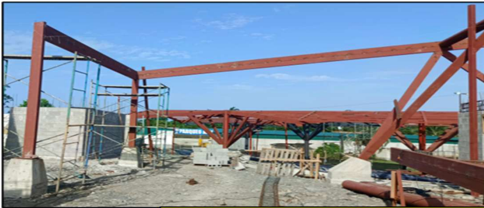
INICIO COLOCACION ESTRUCTURA METÁLICA DEL PASILLO DE LOS LOCALES
