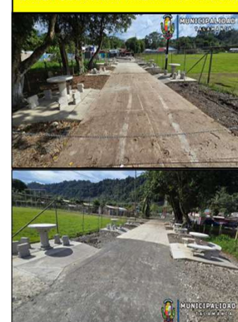
BASES DE BANCAS Y MESAS INSTALADAS
