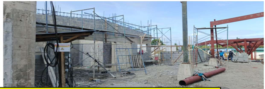
TAPICHELES DE BLOCK EN LOCALES Y LEVANTADO DE PARED EN AREA DE BOLETERIA DE MEPE
