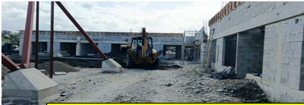
TAPICHELES DE BLOCK EN LOCALES Y LEVANTADO DE PARED EN AREA DE BOLETERIA DE MEPE
