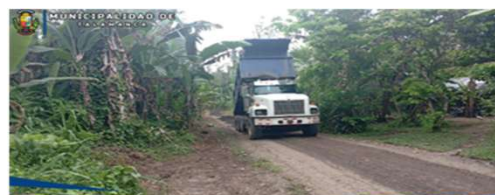
ENTRADA - ESCUELA SANTO TOMAS - TELIRE
