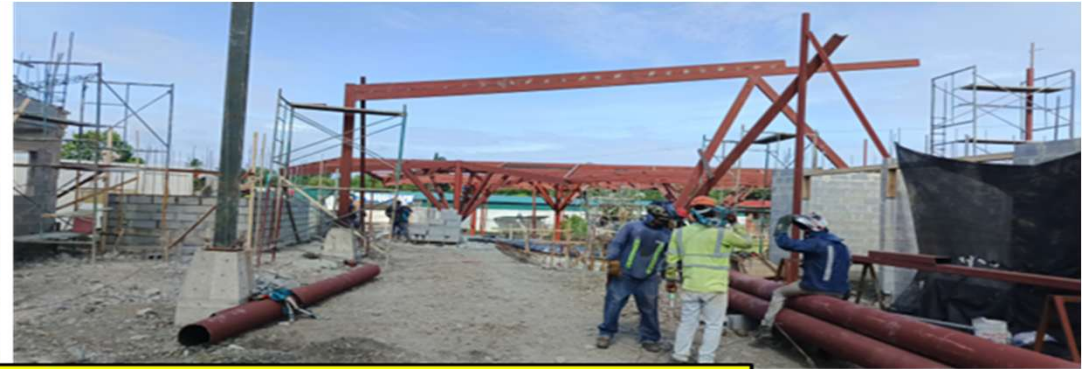
INICIO COLOCACION ESTRUCTURA METÁLICA DEL PASILLO DE LOS LOCALES
