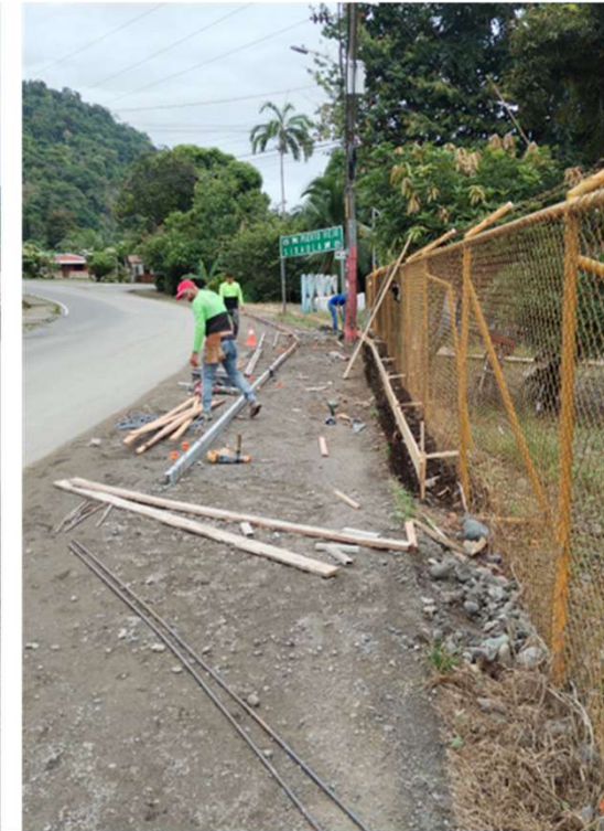
PREPARACION DE FORMALETA PARA CHORREA DE CONCRETO DE ACERA FRENTE A PLANTEL MUNICIPAL
