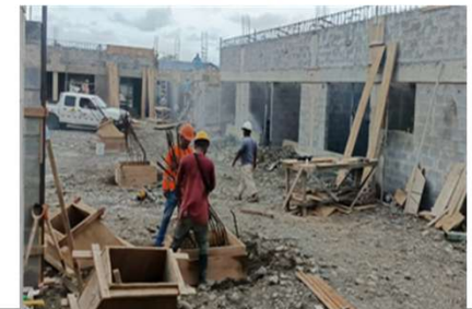
FORMALETEADO Y ARMADURA PARA CHORREA DE CONCRETO – PEDESTALES DE COLUMNAS DEL PASILLO
