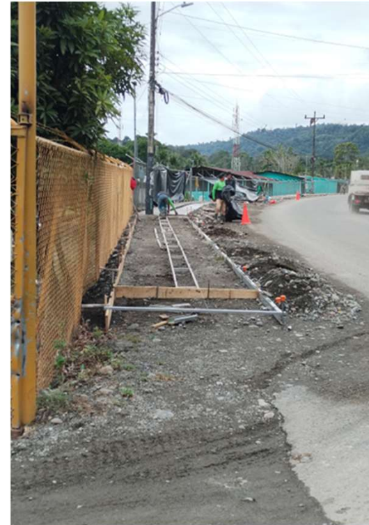
PREPARACION DE FORMALETA PARA CHORREA DE CONCRETO DE ACERA FRENTE A PLANTEL MUNICIPAL
