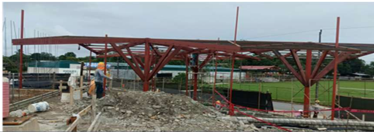
ESTRUCTURA DE TERMINAL DE BUSES - COLOCACION DE CLAVADORES PARA TECHO
