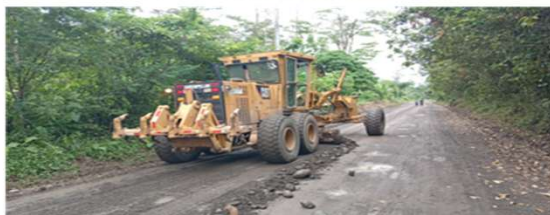
LIMPIEZA DE CUNETAS Y RASPADO DE CAMINO
