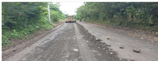
LIMPIEZA DE CUNETAS Y RASPADO DE CAMINO
