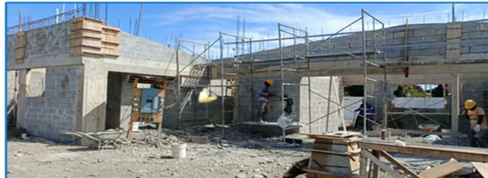
TAPICHELES DE BLOCK EN LOCALES Y CHORREA DE VIGAS Y LOSETAS
