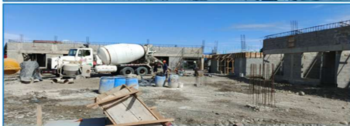
CHORREA DE PEDESTALES PARA COLUMNAS METALICAS EN PASILLO
