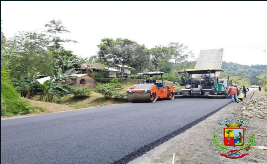
1KM ADICIONAL DE ASFALTO PARA EL CAMINO ENTRE BRIBRI - SURETKA
