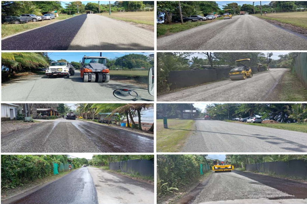
AVANCE DE TRABAJOS EN CAMINO 7-04-010
