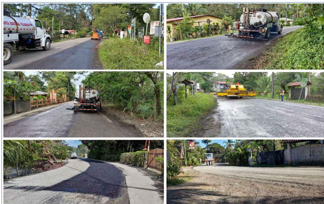
AVANCE DE TRABAJOS EN CAMINO 7-04-010
