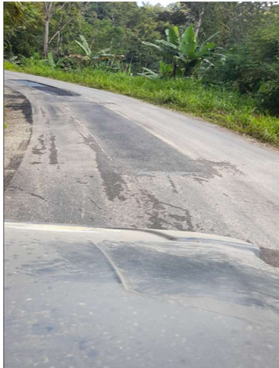
REPARACION DE CARPETA ASFALTICA EN CAMINO 7-04-019
