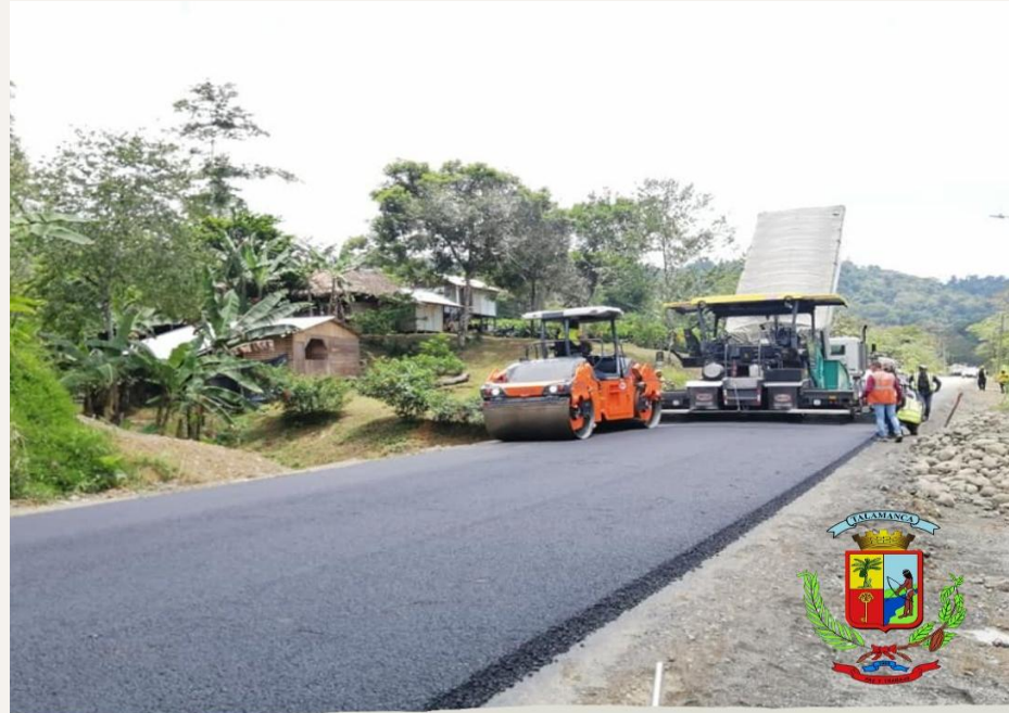
1KM ADICIONAL DE ASFALTO PARA EL CAMINO ENTRE BRIBRI - SURETKA
